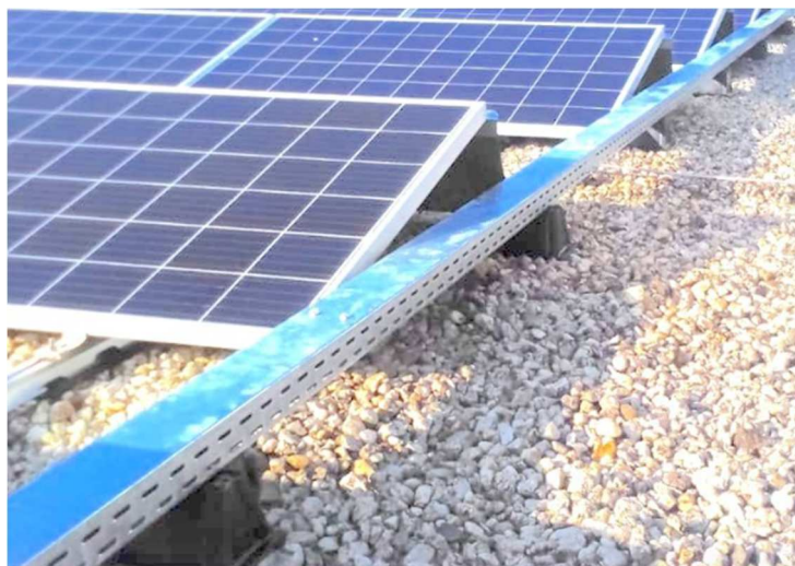
Rys. Przykład wykonanej trasy kablowej DC
